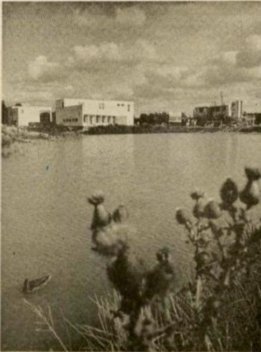
Wonen en werken in het Drachtster Morra Park. Van links naar rechts de buizen van Henk Hoistra, Fokke Haanstra en het in aanbouw zijnde onderkomen van Auke de Vries. Foto LC-Jan de Vries
